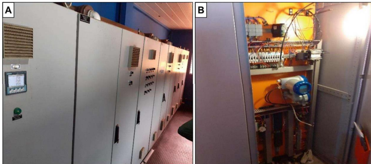
Figura 37: Quadro de comando de captação superficial – (A) parte externa (B) parte interna
