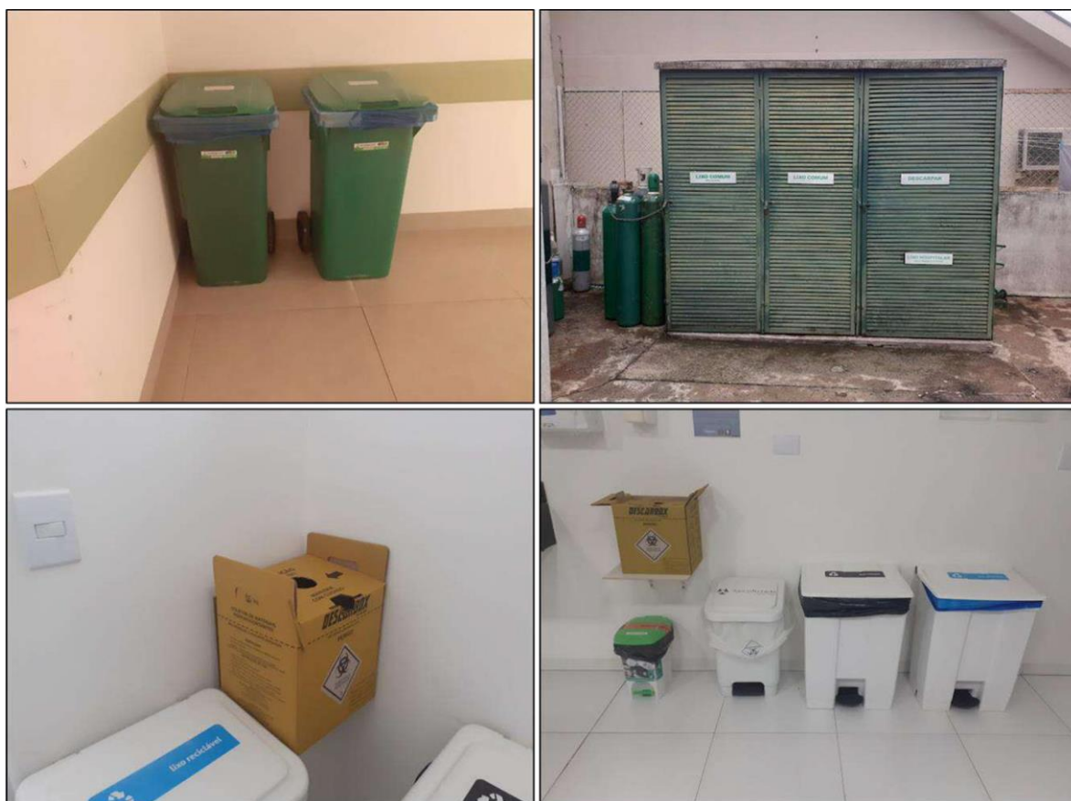
Figura 68: Acondicionamento de RSS na UNIMED
