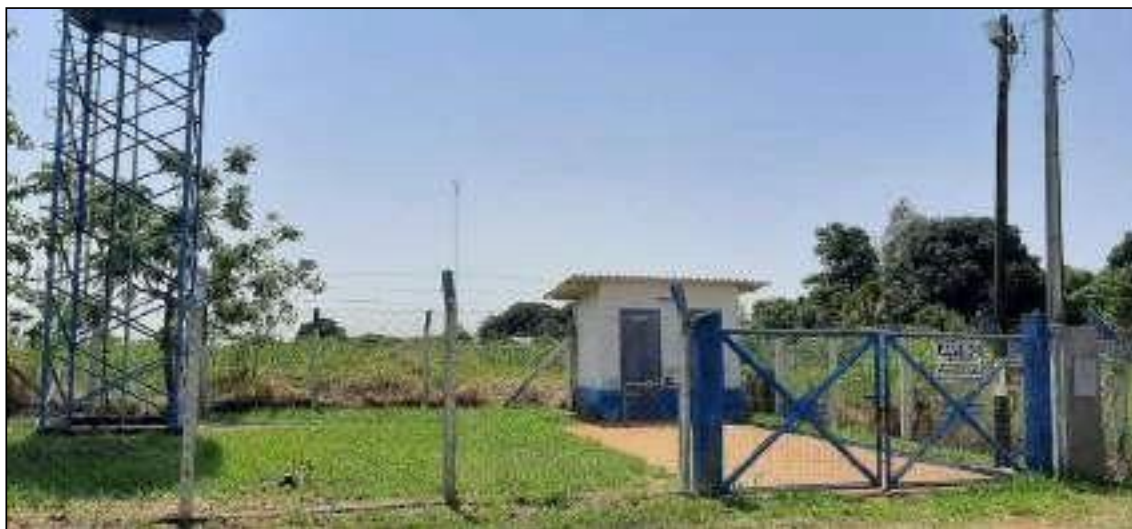
Figura 92: Parte do Sistema de Abastecimento de Água da Vila Rural Nova Vida
