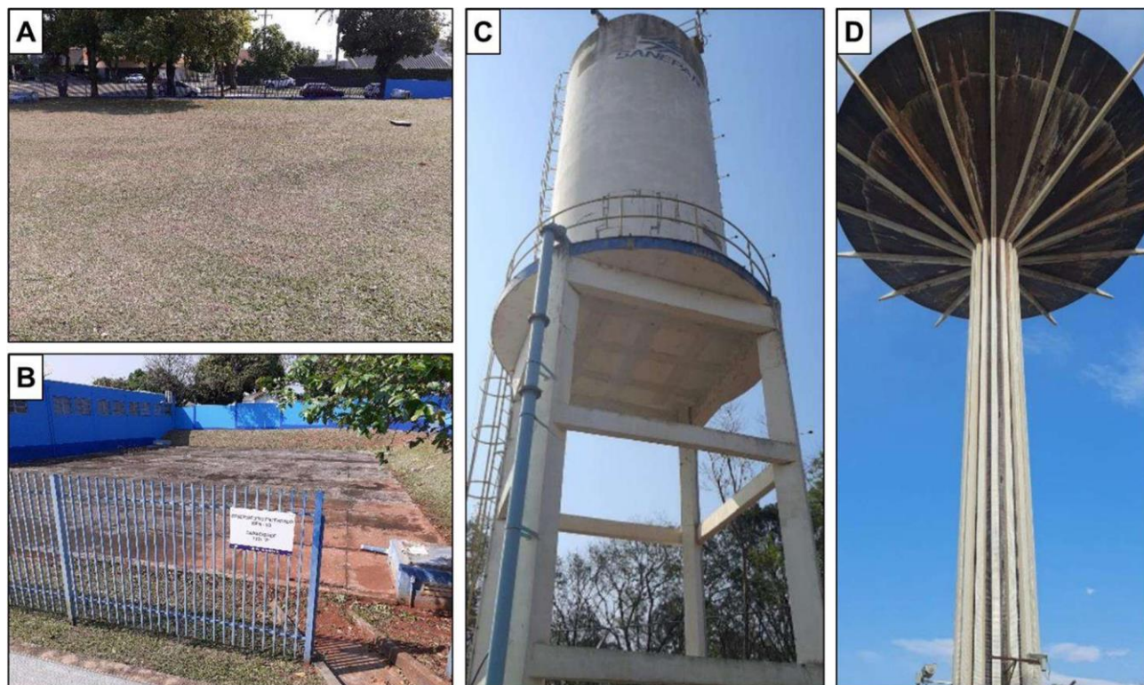
Figura 47: Reservatórios que compõem o sistema de reservação de água de Paranaíba-PR - (A) Reservatório enterrado (ETA); (B) Reservatório enterrado (ETA); (C) Reservatório elevado (Oásis); (D) Reservatório elevado (Santos Dumont)
