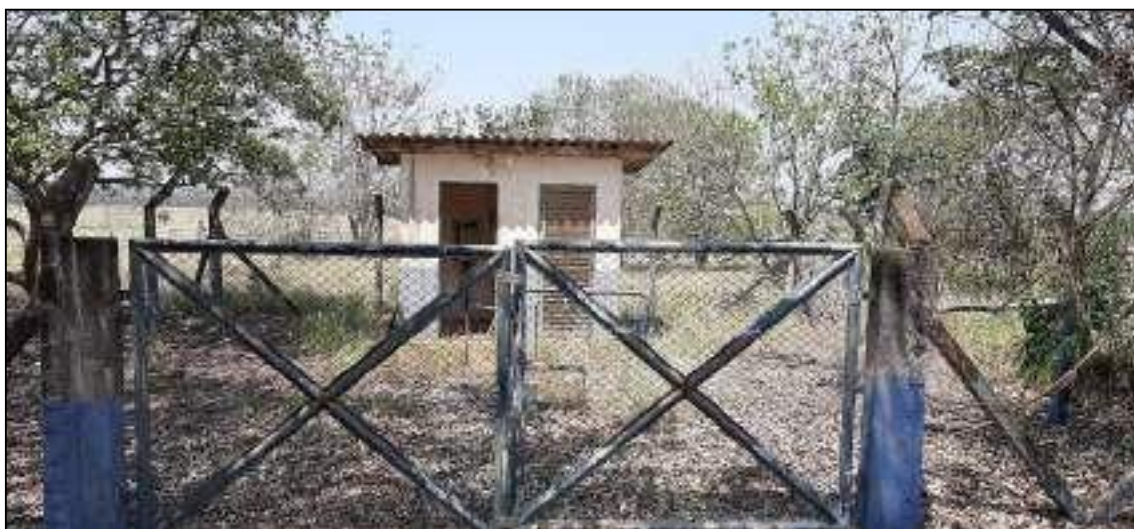
Figura 95: Parte do Sistema de Abastecimento de Água da V. R. Monte Alto
