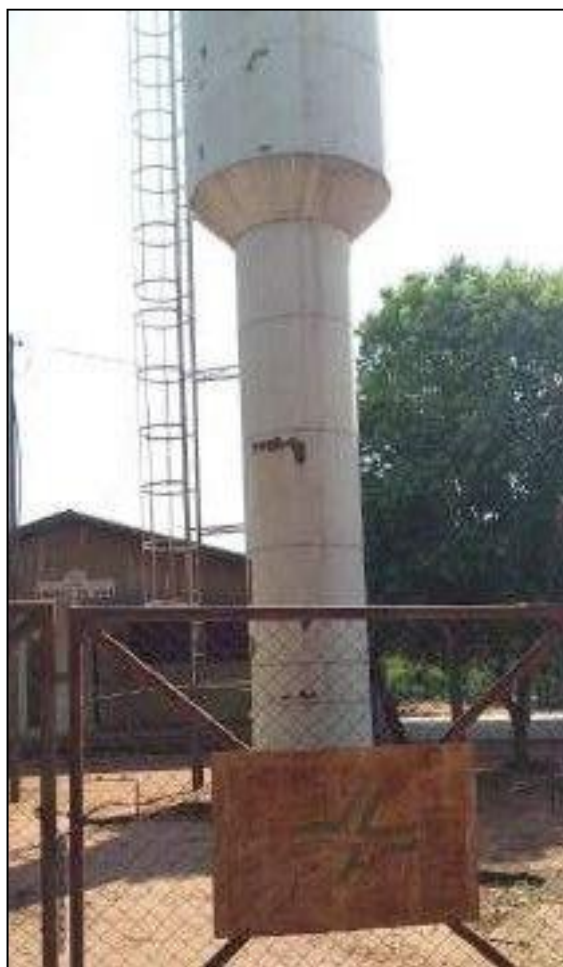
Figura 89: Reservatório Elevado na Vila Rural Água Dourada
