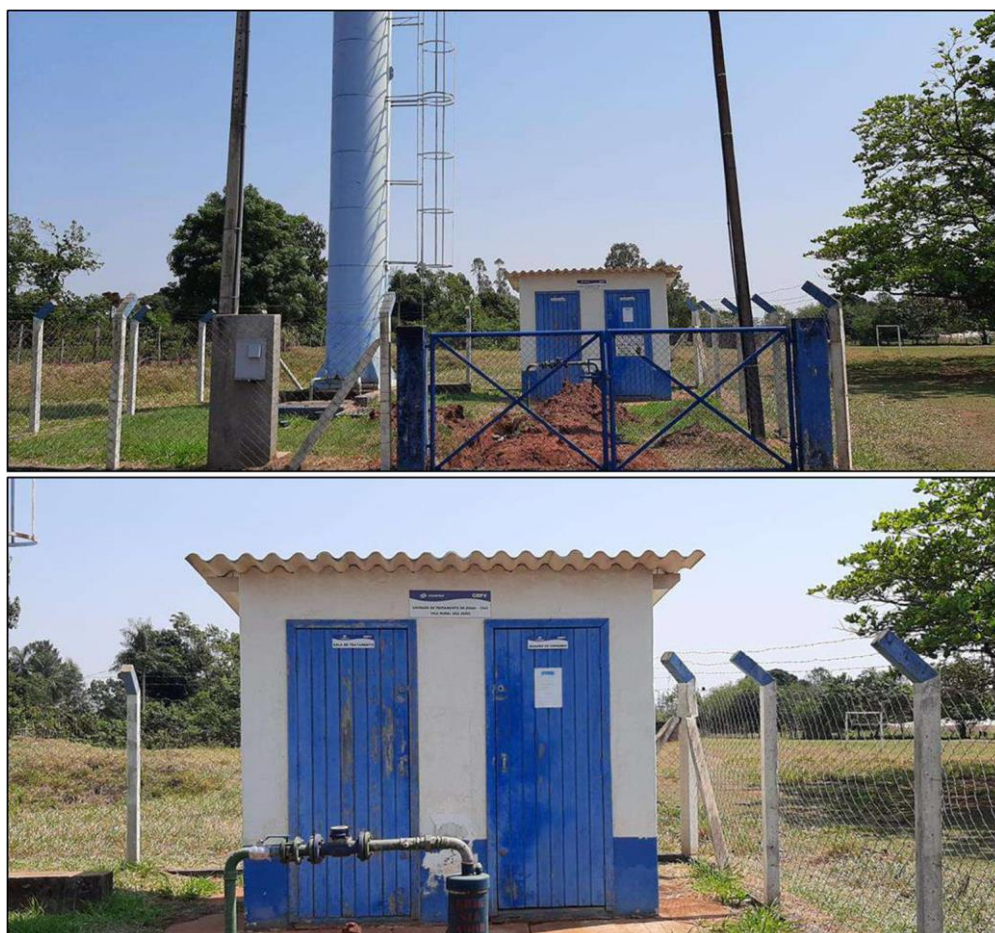
Figura 90: Parte do Sistema de Abastecimento de água da V.R. São João
