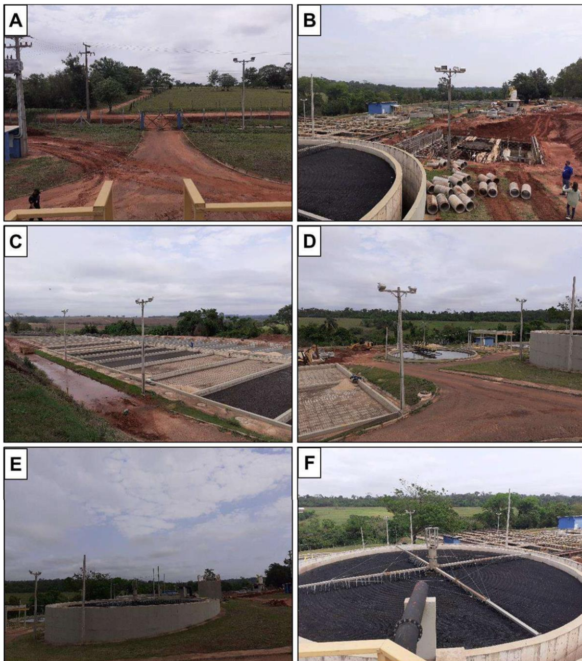
Figura 57: Visão geral da ETE vila Operária que se encontra em reformas - (A) Entrada da ETE; (B) Reformas; (C) Leito de secagem; (D) Decantador; (E) Filtro biológico; (F) Filtro biológico
