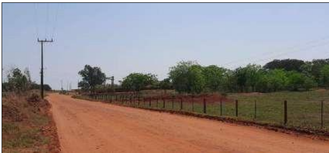
Figura 91: Acesso à Vila Rural São João
