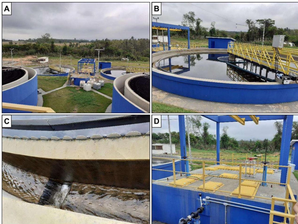
Figura 53: Sistema de pós-tratamento formado por decantadores - (A) Visão geral do sistema; (B) Decantador; (C) Efluente clarificado; (D) Casa de química
