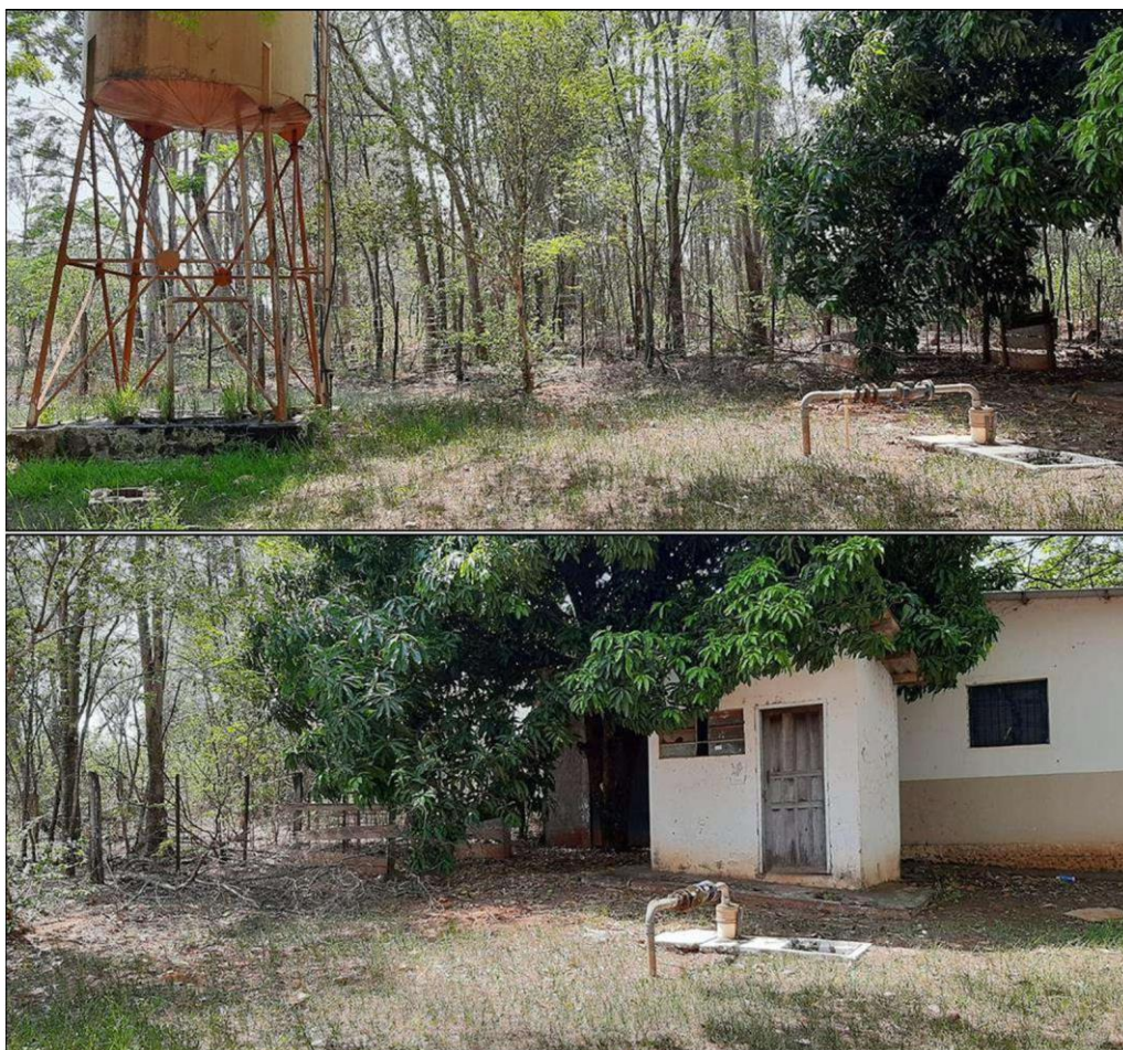
Figura 88: Parte do Sistema de Abastecimento de Água do Distrito de Piracema
