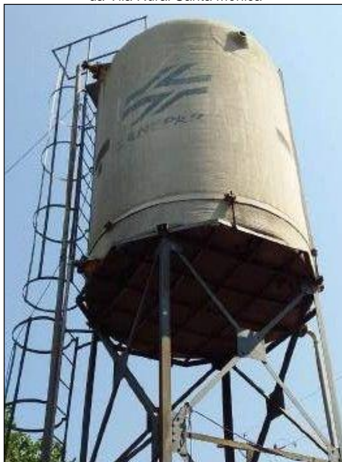
Figura 97: Reservatório Elevado: Parte Integrante do Sistema de Abastecimento de Água da Vila Rural Santa Mônica
