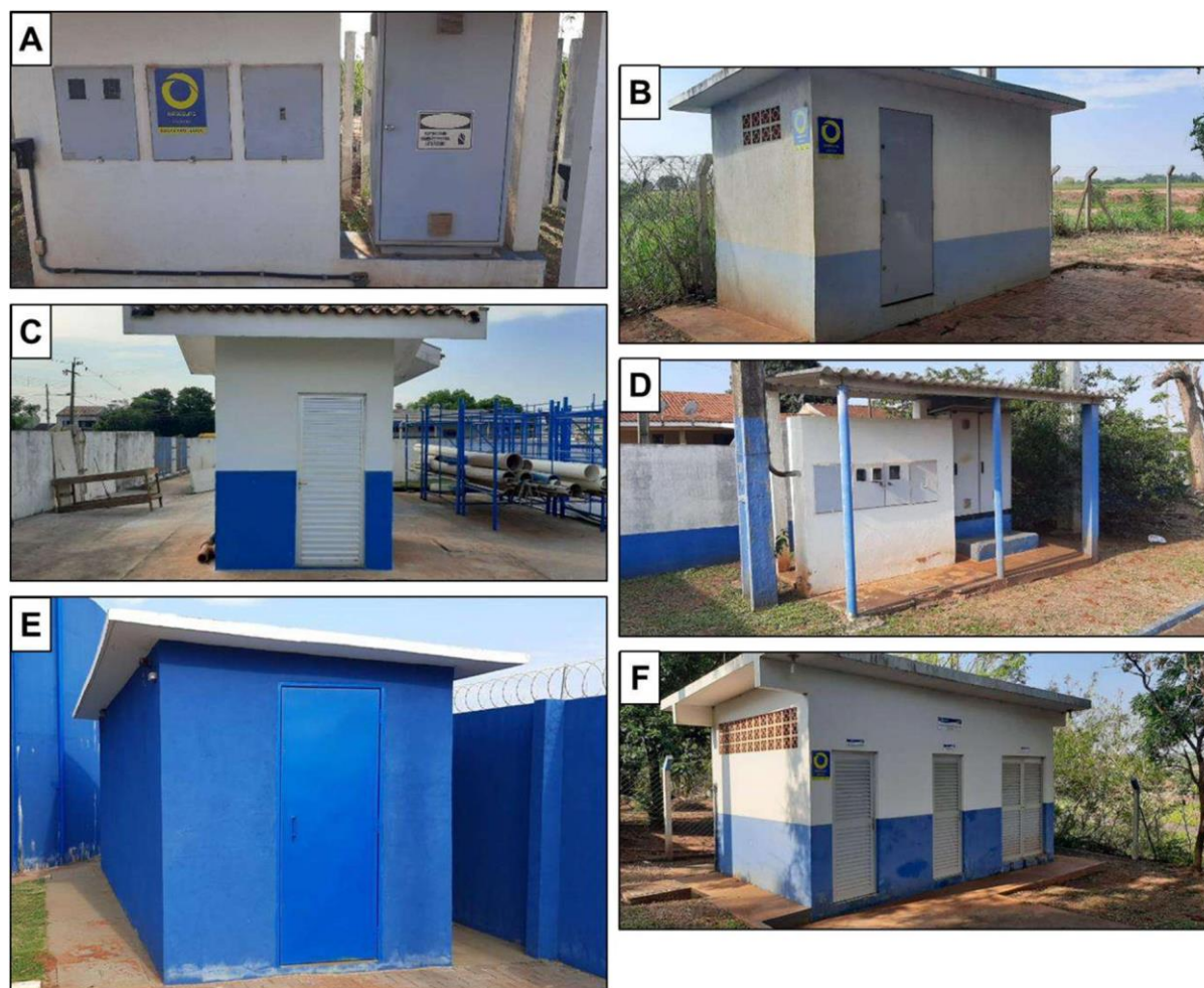
Figura 38: Abrigos e quadro de automação de poços - (A) CSB6; (B) CSB 16; (C) CSB 5; (D) CSB 9; (E) CSB10; (F) CSB 14
