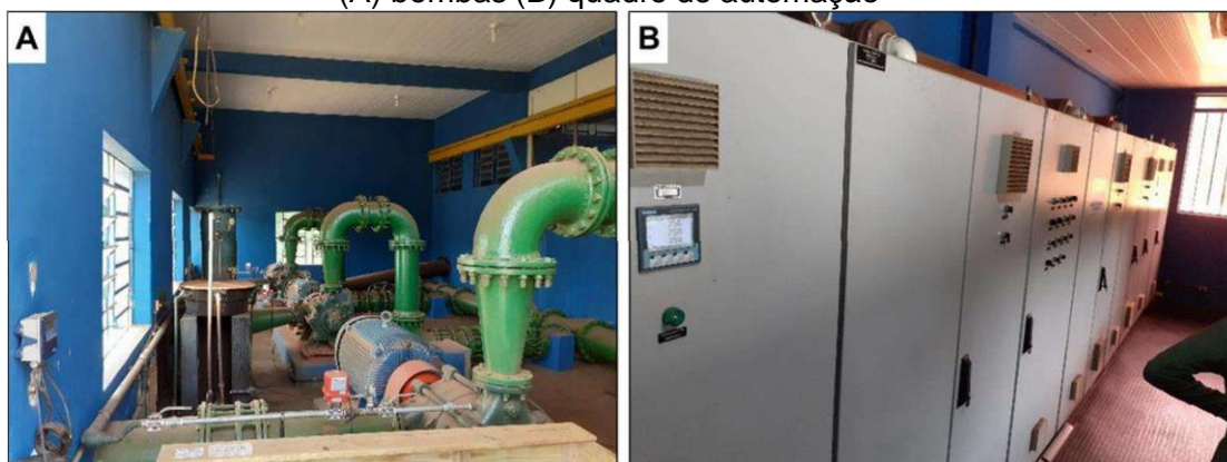
Figura 35: Bombas de captação de água do Ribeirão Araras e quadro de automação – (A) bombas (B) quadro de automação
