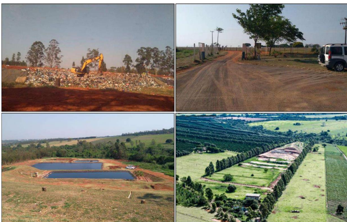
Figura 74: Aterro Sanitário de Paranaíba
