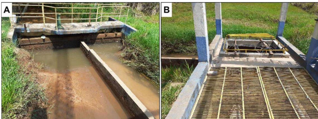
Figura 33: (A) Ponto de captação do Ribeirão Floresta; (B) proteção das bombas
