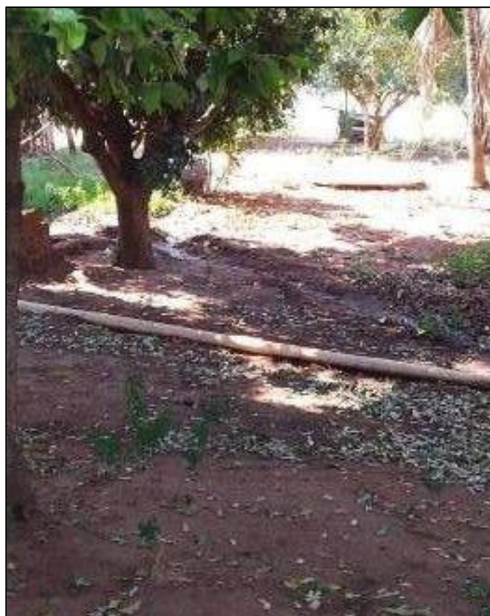
Figura 94: Esgoto a Céu Aberto na Vila Rural. José Dolvino Garcia
