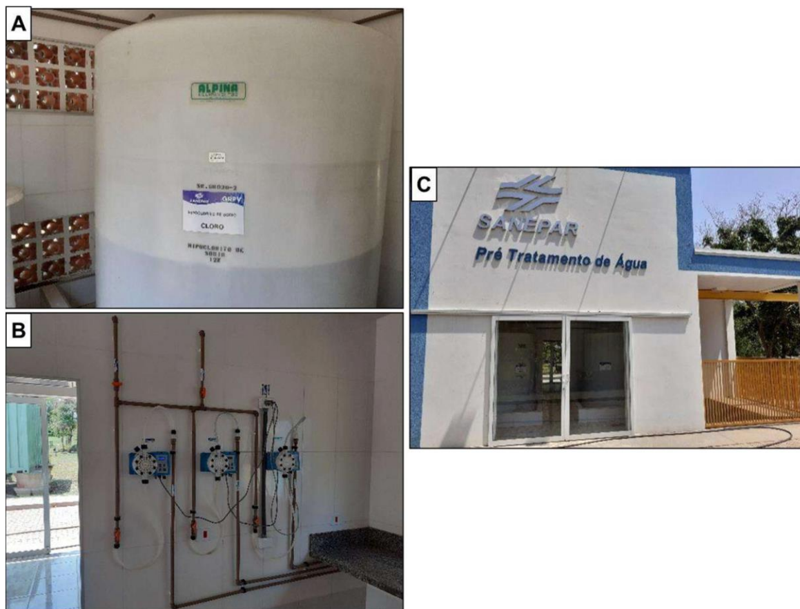
Figura 40: Pré-tratamento na captação – (A) tanque de cloro; (B) dosadoras; (C) abrigo para o pré-tratamento
