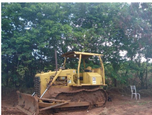
Trator de esteiras para espalhamento de resíduos
