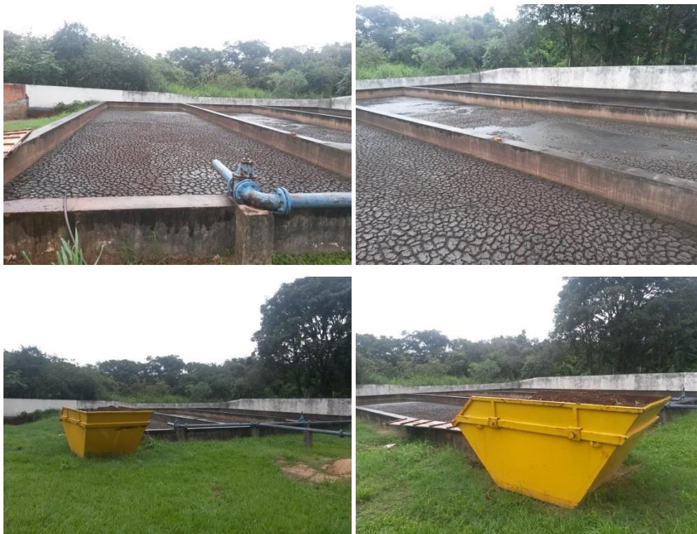
Figura 163. Leitos de secagem do lodo da ETE Fonte: HABITAT ECOLÓGICO, 2015.
