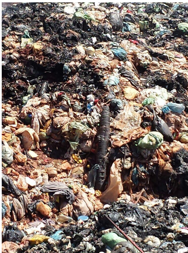
Figura 92. Dreno do chorume destruído devido a má operação Fonte: ITEDES, 2014.
