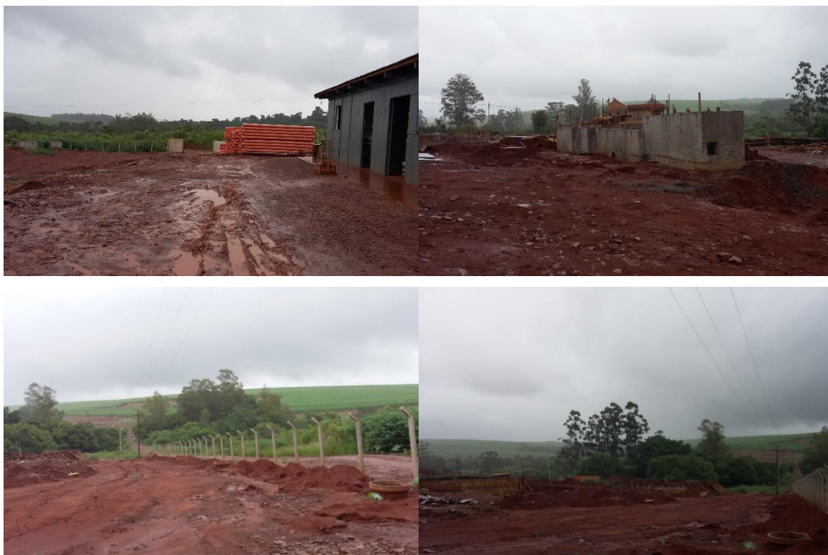
Figura 56. Estação de tratamento de Esgoto em Construção – SANEPAR Fonte: HABITAT ECOLÓGICO, 2015.
