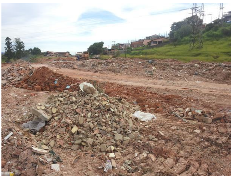
Figura 243. Localidade em Itabira-MG licenciada para recepção de RCC inertes Fonte: Paraná Ambiental, 2015.
