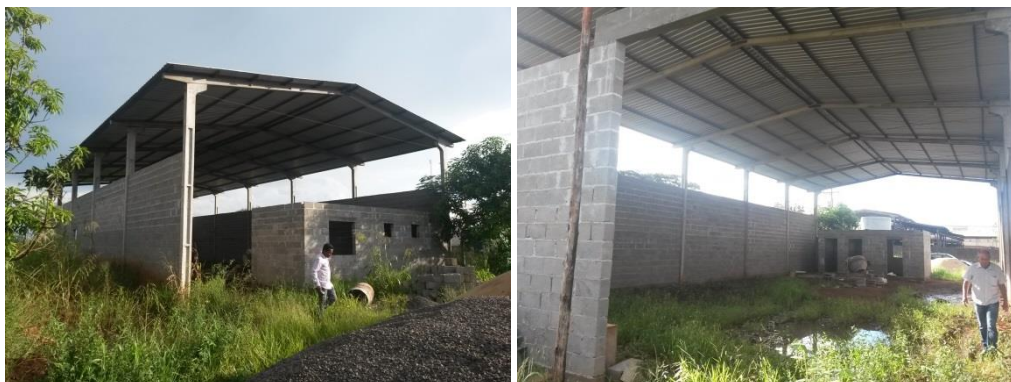
Figura 159: Barracão para triagem em construção Fonte: HABITAT ECOLÓGICO, 2015.
