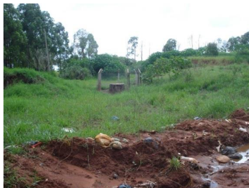
Poço de chorume para reciclagem
