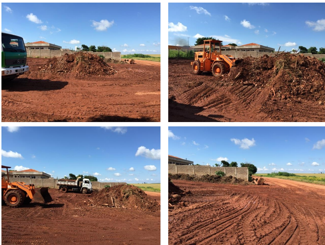
Figura 136. Área para disposição de Resíduos de Construção Civil Fonte: HABITAT ECOLÓGICO, 2015.
