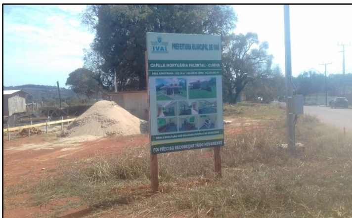
Capela Mortuária no Palmital - Início da Obra
