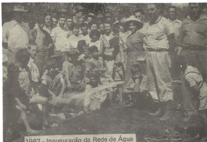
1962 - Inauguração da Rede de Água
