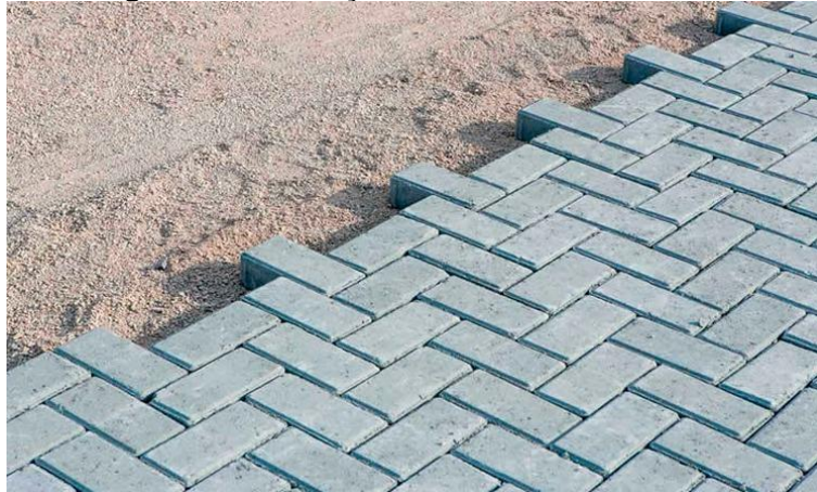
Figura 15: Instalação de blocos intertravados.
