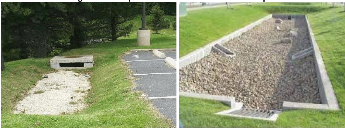
Figura 9: Exemplos de valas/trincheiras de infiltração.
