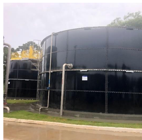
Imagem 12 Vista dos tanques de tratamento
