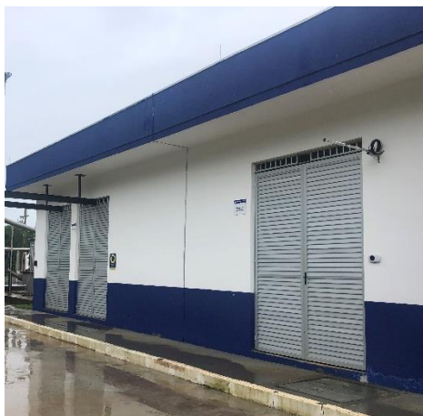
Imagem 13 Vista do prédio de controle do sistema de tratamento da ETE
