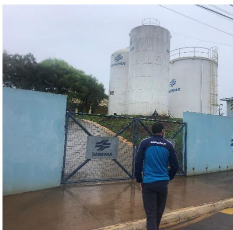
Imagem 7 Vista frontal dos reservatórios do município de Turvo-PR
