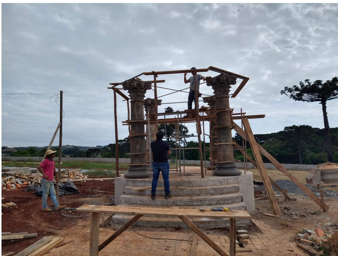
🚧 Portal e Muro do Cemitério Municipal
