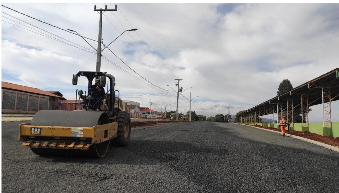
🚧 Pavimentação Rua Miguel Padilha
