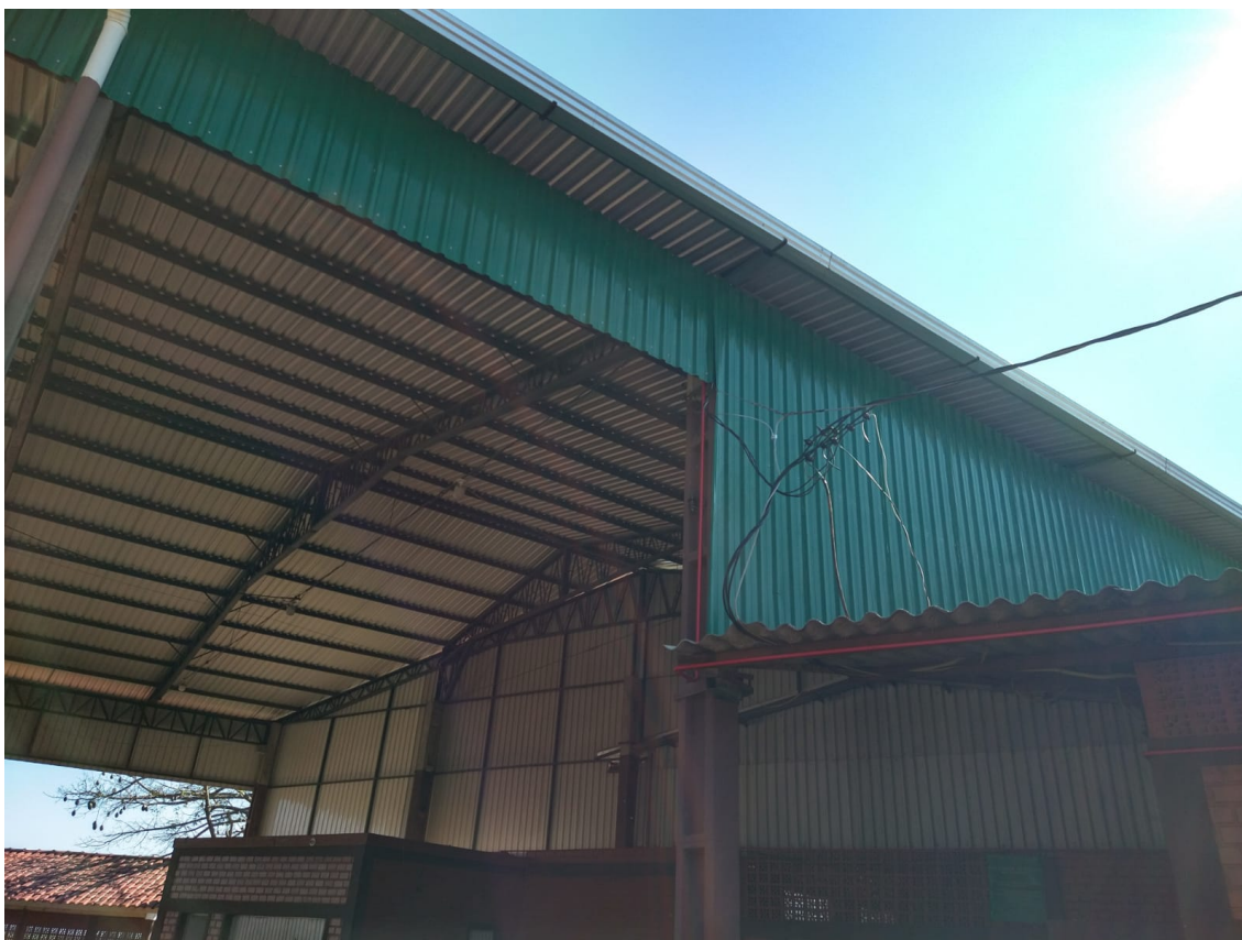
▣ Execução da rede de Hidrante do Centro de Eventos Municipal
