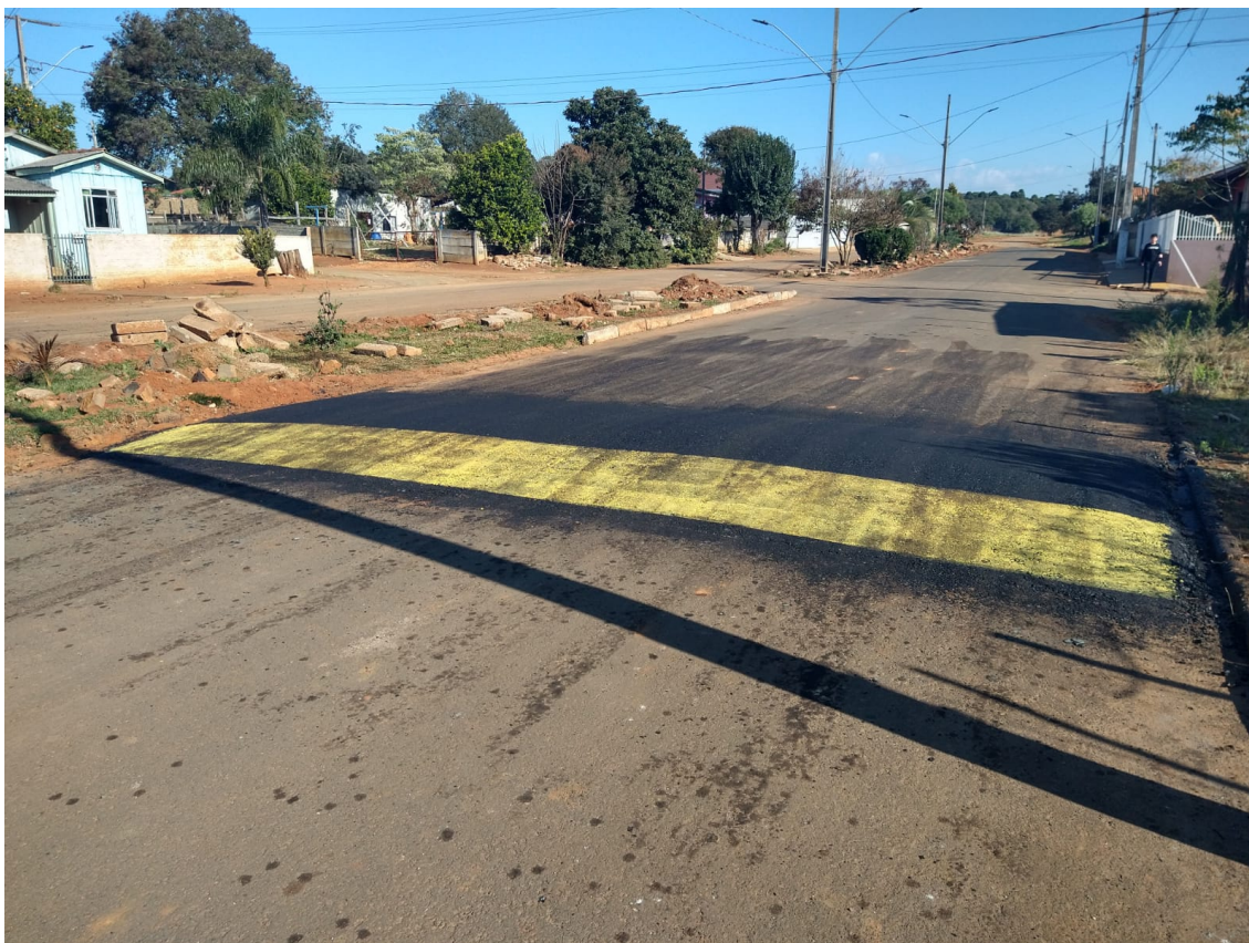
🚧 Lombadas e meio fio Bom Jardim
